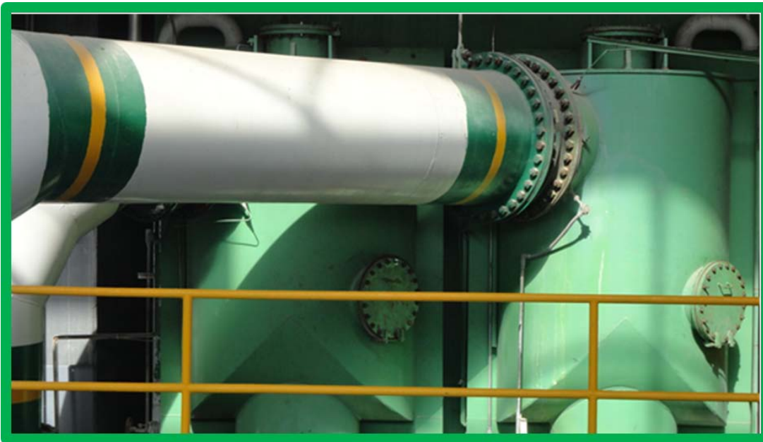
Ilustración 15 Cajas de agua de condensador principal.
