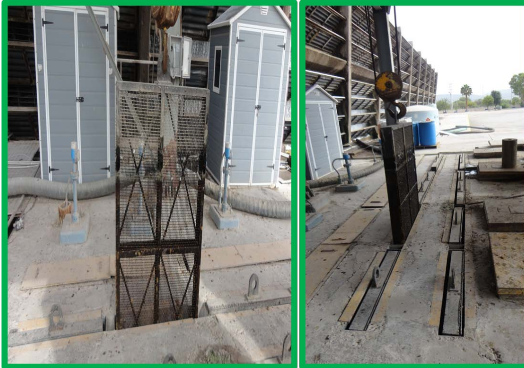
Ilustración 14 mayas para filtrado de succión de bombas de condensado.
