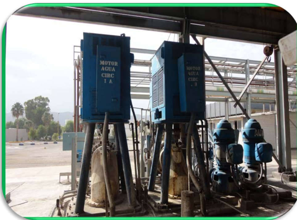
Ilustración 12 bombas de sistema de circulación.
