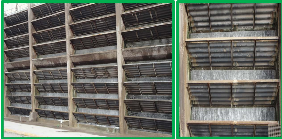
Ilustración 7 persianas de torre enfriamiento.
